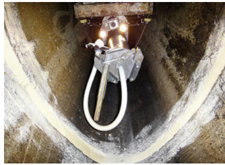
Bild 4: Spachtelarbeiten im Eiprofil
