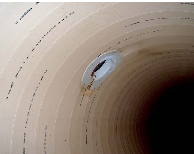
EINBINDUNG DES ANSCHLUSSES: mit dem PVC-hatform-fix-System
