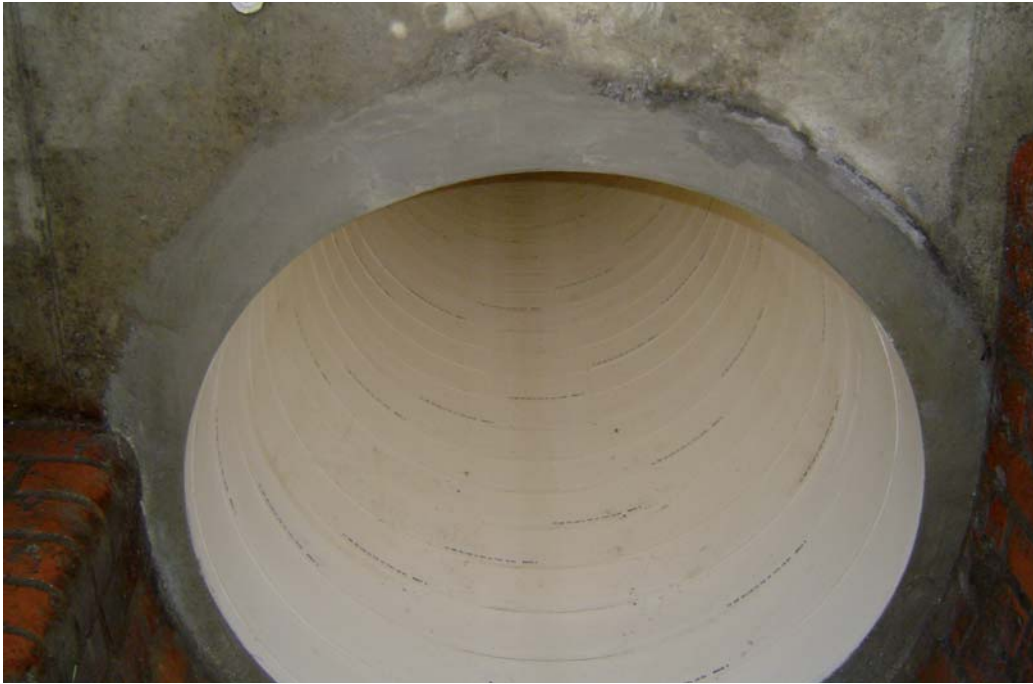
WICKELROHR: am Schachtanschluss
