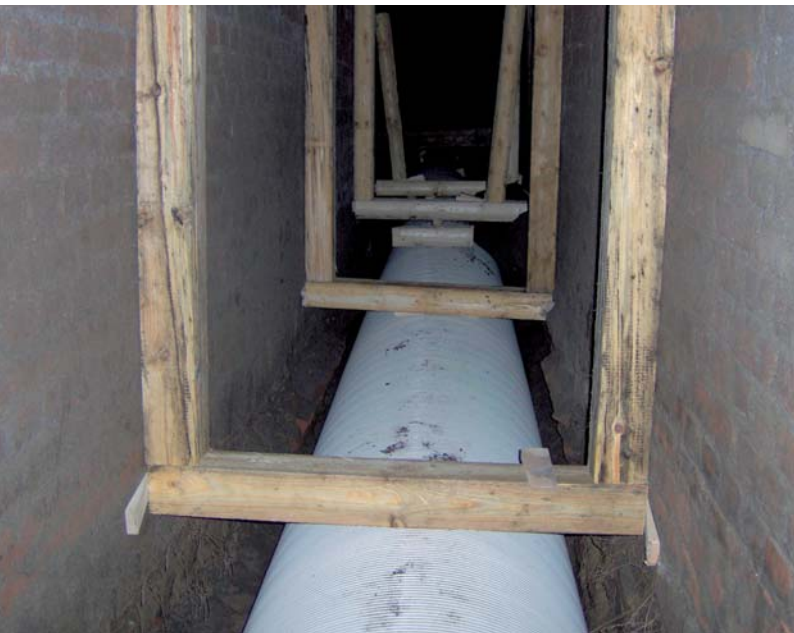
VERBAUTES WICKELROHR: vor der Verdämmung
