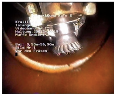
Bild 6: Vor der EDS-Sanierung
