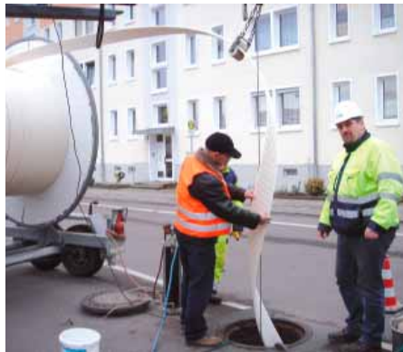
Wickelrohtrommel, Materialprüfung durch den Auftraggeber
