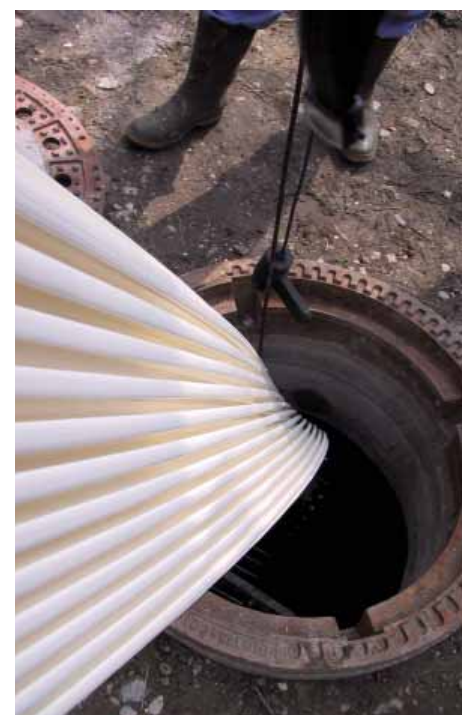
Profilzuführung in den Schacht
