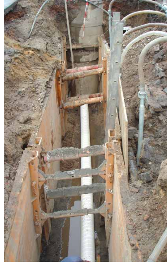
Einbau des SWP-Wickelrohres durch die Baugrube hindurch
