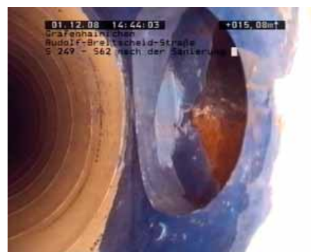
Anschlusseinbindung mittels KATE – Robotersystem
