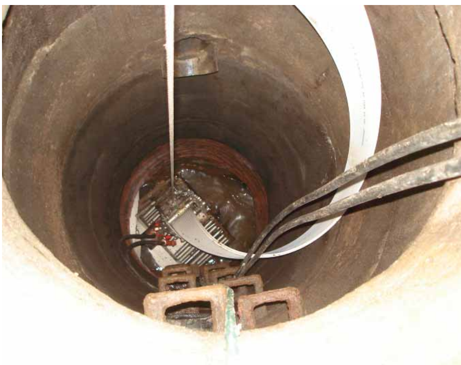
SWP – Wickelmaschine im Schacht
