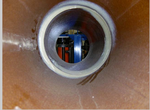
Mit EDS – System sanierte Muffe, bündig mit Rohrwand
