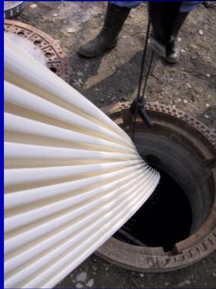
Kanalsanierung mit Wickelrohrtechnik - Dipl. Ing. univ. Thomas Palaske
