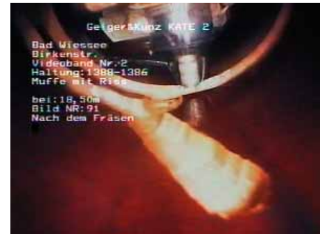
Risse und Muffen Fräsen mit Nutenfräser.
