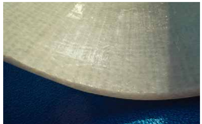
Ausgehärteter Inliner nach UV-Lichtlinersystem Berolina.
